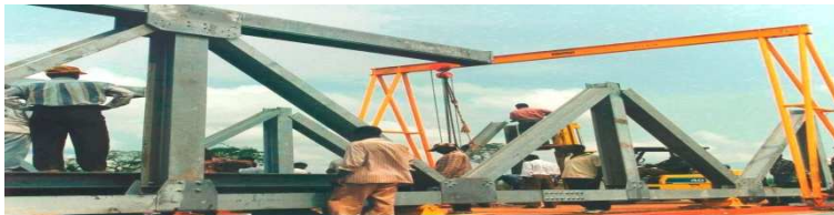
Fotografía Superior Muestra de cómo se monta el puente al proceso de armado de uno de los pilares. Fotografía Inferior Muestra el puente ya armado con el pila de montaje, listo
